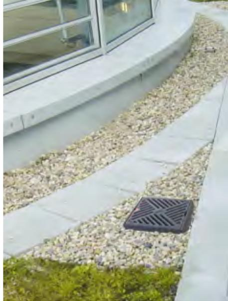
Zur sicheren Ableitung des versickerten Regenwassers auf Gründächern bietet ACO Flachdachabläufe und Aufsätze aus Polymerbeton und Guss an. Sie sind leicht zu handhaben und lassen sich stufenweise an die verschiedenen Dachbegrünungsvarianten anpassen.
