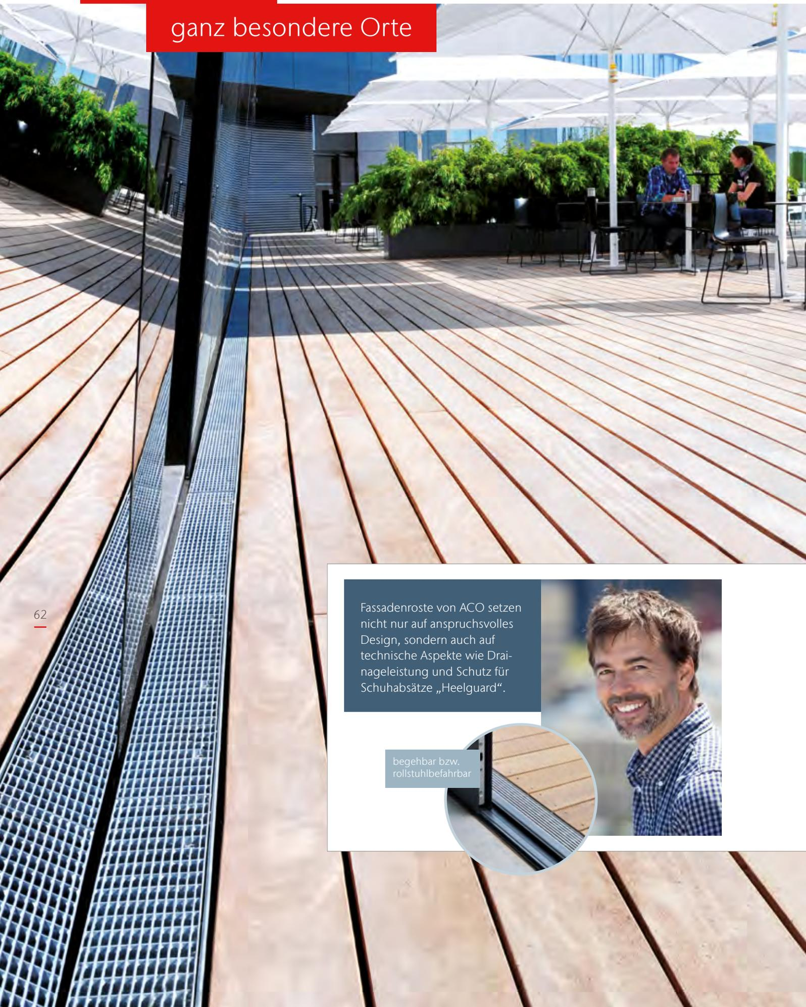
Fassadenroste von ACO setzen nicht nur auf anspruchsvolles Design, sondern auch auf technische Aspekte wie Drainageleistung und Schutz für Schuhabsätze „Heelguard“.
