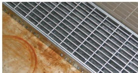
Ein eingelegtes Schmutzvlies reduziert bereits im sauberen Zustand die hydraulische Leistung des Systems um 30%
