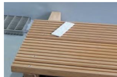
Lägg några distanser under rännan för att uppnå önskad installationshöjd.
