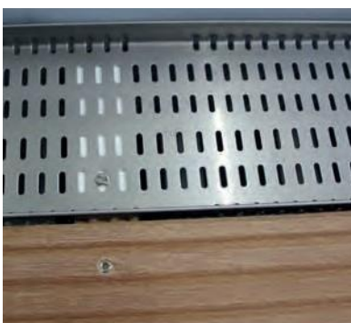
Skruva fast rännsektionen genom de 4 mm stora dräneringsslitsarna i rännans botten.
