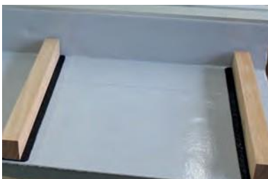
Lägg bjälkarna på tätskiktet. Det rekommenderade c/c-avståndet är 500 mm.
