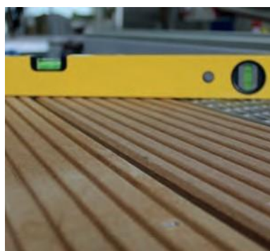
Kontroll av installationshöjden.
