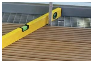
Montering av fasadrännan. Kontrollera så att installationshöjden blir samma som kringliggande trall. Mät avståndet om rännan måste höjas.
