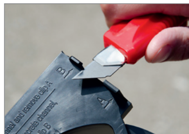
2. Skär bort fäste B på höger och vänster sida med en kniv
