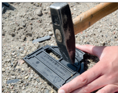
1. Gavelutlopp kan enkelt skapas genom att knacka ur de perforerade delarna i gaveln.
