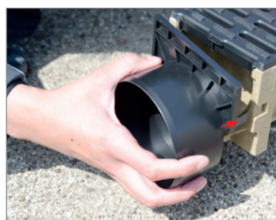
5. Montera gavelutloppet så de båda fästena klickar i rännans urspårning
