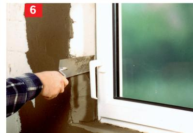
Fugen innen dampfdicht und außen schlagregendicht und diffusionsoffen abdecken. Zum Abschluss das neue Fenster sauber einputzen.
