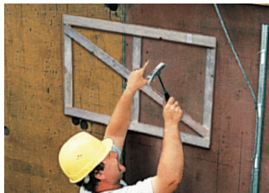
3. Stützkreuz auf der Schalung befestigen.
