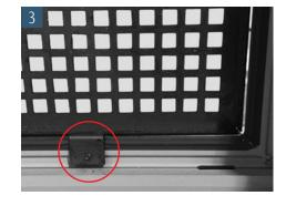
Die Schrauben sind selbstschneidend. Nur handfest verschrauben. Danach kann der Flügel eingesetzt werden
