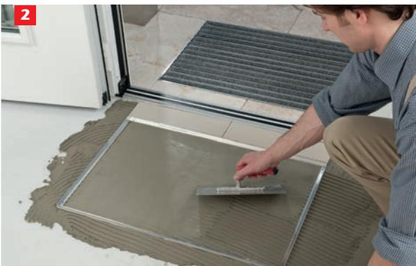
Um eine plane Auflage für die Matte herzustellen, Fliesenkleber bündig an die Rahmenunterkante anarbeiten.
