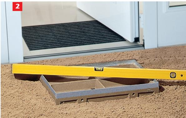
Die Bodenwanne des Schuhabstreifers auf den Untergrund setzen und ausrichten.
