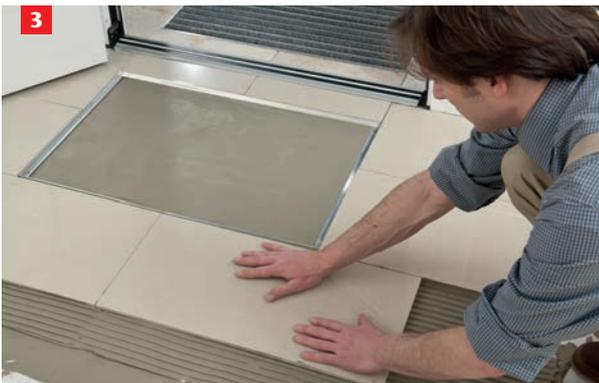
Anschließend den Bodenbelag anarbeiten. Berücksichtigen Sie eine schmale Dehnungsfuge.
