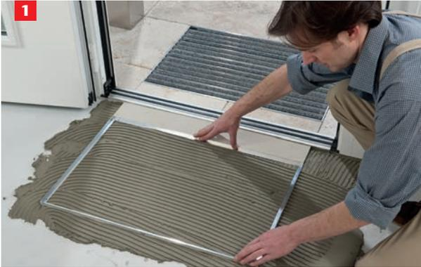
Den Winkelrahmen auf den vorbereiteten Fliesenkleber setzen, ausrichten und andrücken.
