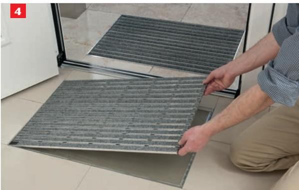
Legen Sie zum Abschluss die Indoor Schuhabstreifermatte nach der Trocknungsphase in den Winkelrahmen ein.
