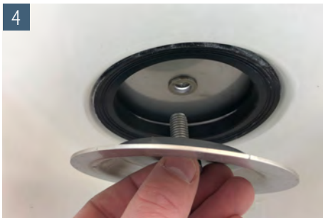
4 Oberen Deckel mittels Schraube mit dem unteren Deckel verschrauben
