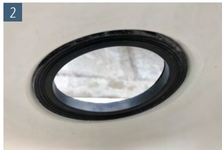
2 Auf den korrekten Sitz der Dichtung ist zu achten
