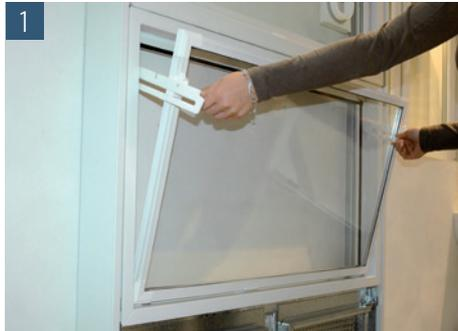
1 Durch Entriegeln der Knebel das Fenster auf Kipp stellen. Das Entfernen erfolgt in umgekehrter Reihenfolge!
